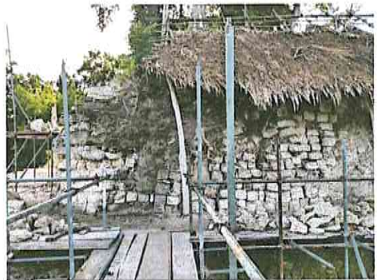
Trabajos de restauración en esquina noroeste extremo lado norte.
