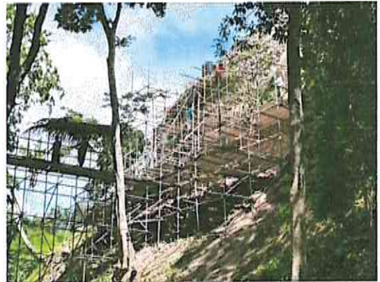
Edificio B-24, fachada sur.
